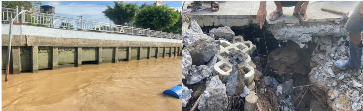
Hình 5. Hình ảnh tằm đan và sụt lún thân kè PĐ. IV, 2022.
